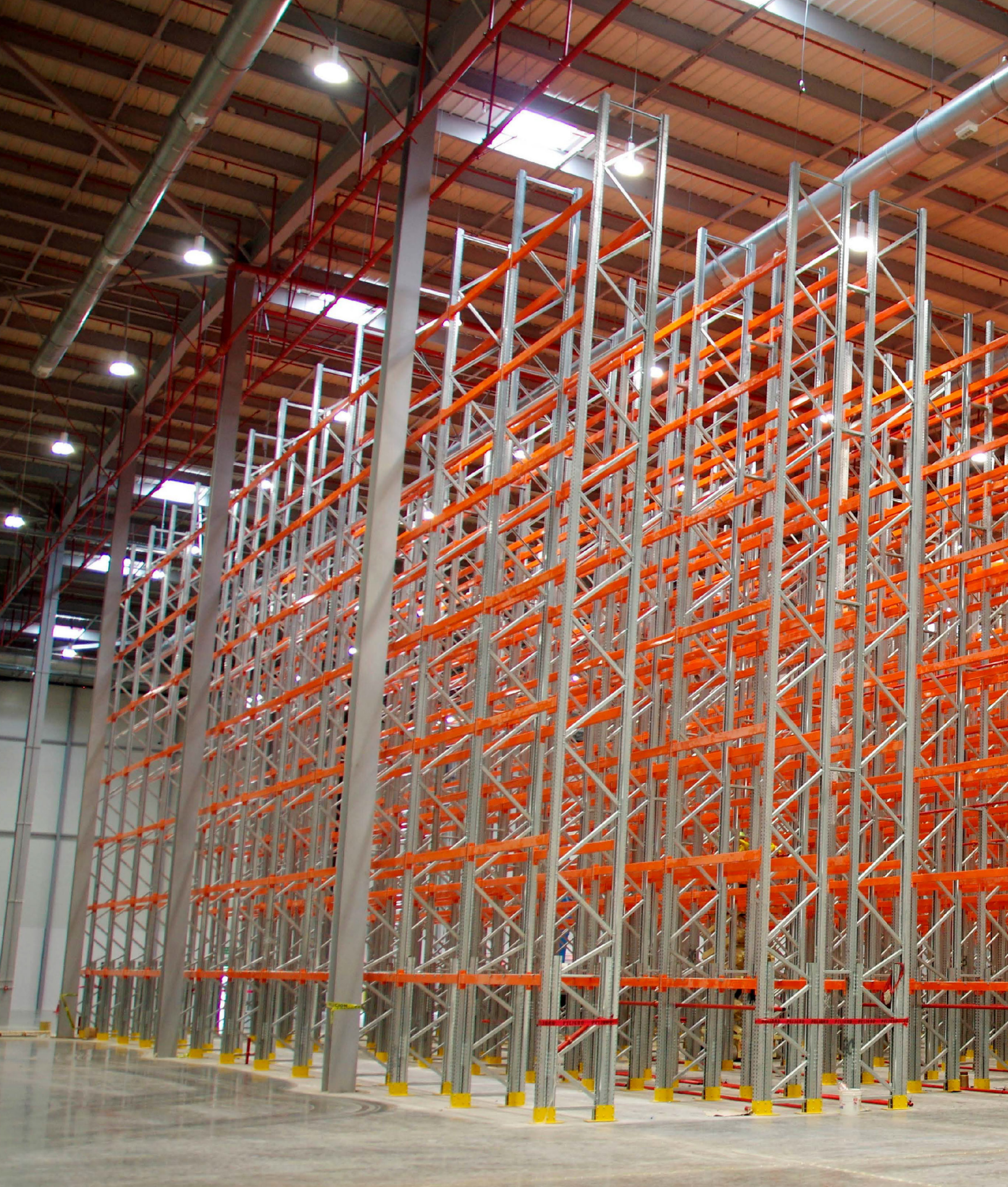
SISTEMA SELECTIVO DE PROFUNDIDAD SENCILLA
